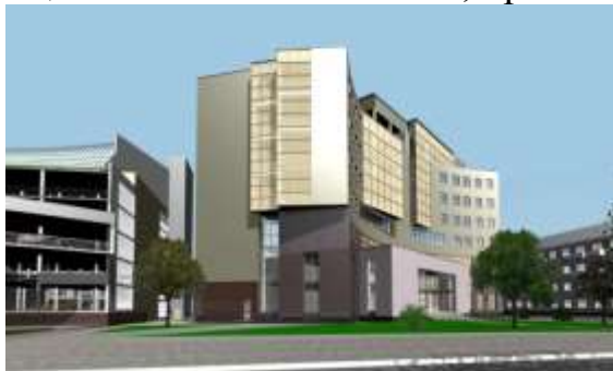
Рис. 2 Общественно-торговый центр «Sadovaya Plaza»
